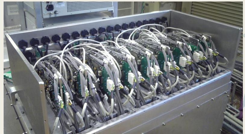
エレクトロニクスボックス内部
