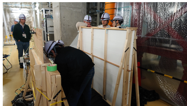
図 4.28 インストール風景その 2. 各々分担しながら作業を進める. インストール自体はとても順調に進んだ.
