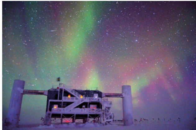
南極点に建つIceCube実験制御室。氷の下には5165個の検出器が埋められており、制御室とつながったケーブルで電源を供給し、検出器が氷中で捉えたニュートリノ反応のデータ受信などを行っている。
