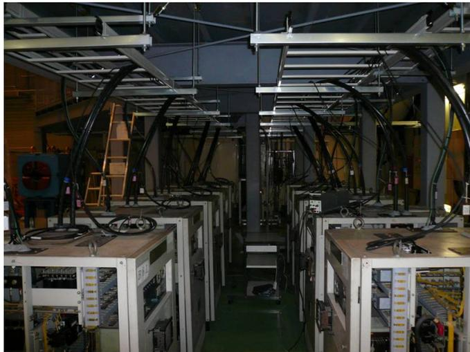
図 4.8: 富士 B4 フロアに設置されたビームラインマグネットの電源。
