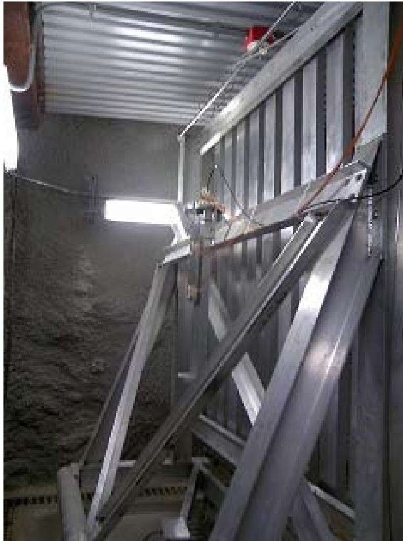
図 4.5 NuMI muon monitor の架台上に設置されたミュオンモニター試作機の写真。
