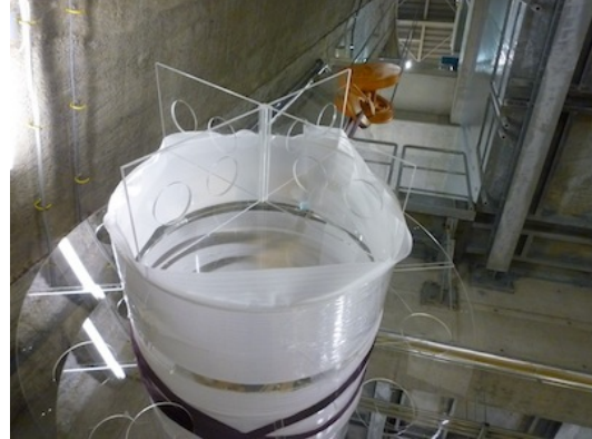
図 5.42: 内タンクのインストール風景。内タンクもクレーンを使って丁寧にホール地下2階まで降ろされた。
