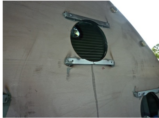
図 5.40: 窓部分の水漏れ箇所。水漏れ箇所はフタ部分に 1 箇所（この図）、タンク上部に 2 箇所あった。全箇所とも接着状態が悪かったため隙間から水漏れが生じたと思われる。再接着後の試験では水漏れは起こらなかった。
