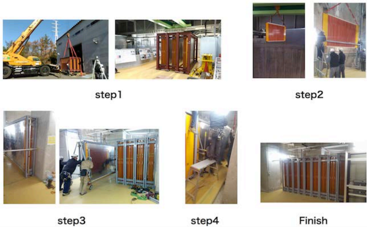
図 4.3.1 Baby MIND インストール中の写真。step1. ニュートリノモニター棟の地上階からインストールを行う場所にクレーンで移動させる。step2. モジュールを一つ一つクレーンで持ち上げて B2 フロアに移動させ、フレームに収納していく。step3. モジュールを収納したフレームを所定の場所に移動させる。step4. 最下流の検出器をインストールする。
